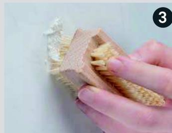
**3** Rückstände bei rauen Oberflächen gegebenenfalls mit Silikonentferner oder Aceton und Wurzelbürste entfernen.
